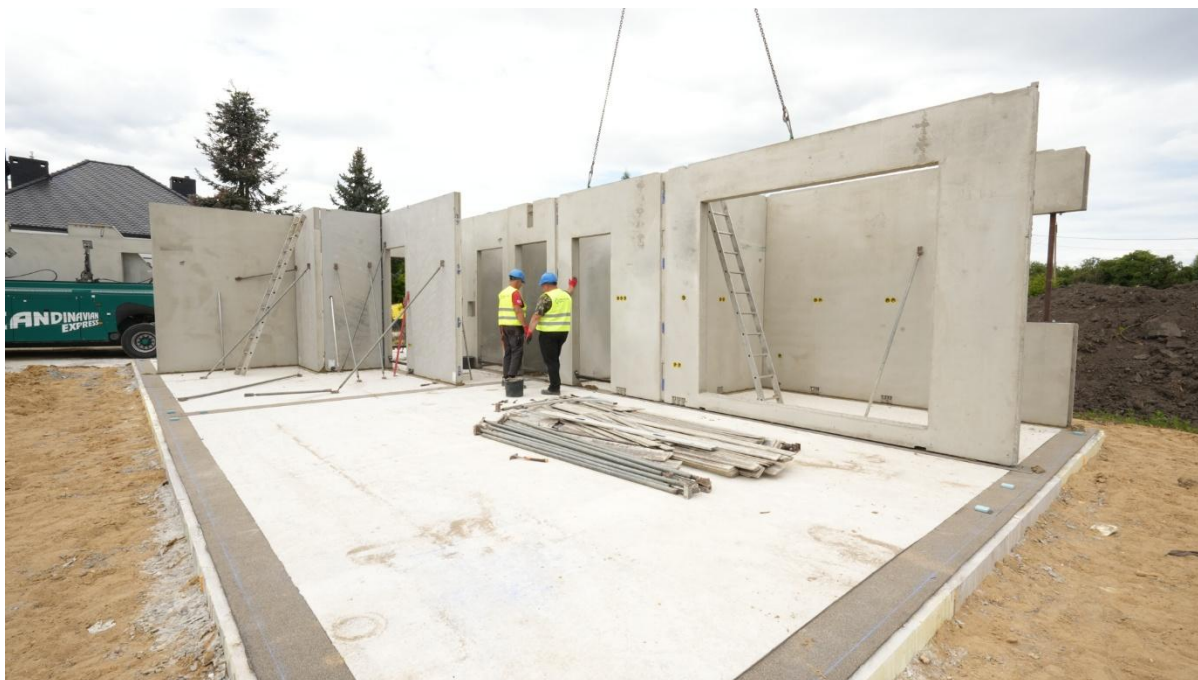
Ryc. 3 Budowa domu z prefabrykatów keramzytobetonowych. Baza własna Extradom.pl
